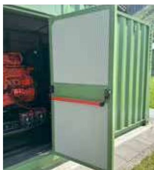
Große Zugangstür auf beiden Längsseiten mit Panikbeschlag
