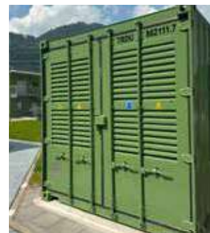
2-flügelige Wartungs- und Zugangstüren vorne mit Zuluftöffnung
