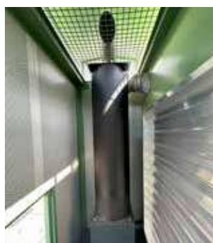
Industrie-Schalldämpfer innenliegend sowie elektrische Abluftklappe serienmäßig
